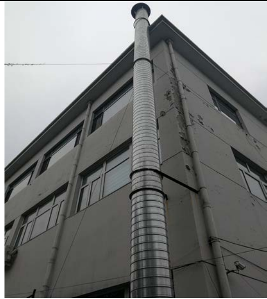
印刷工序15m排气筒P1
